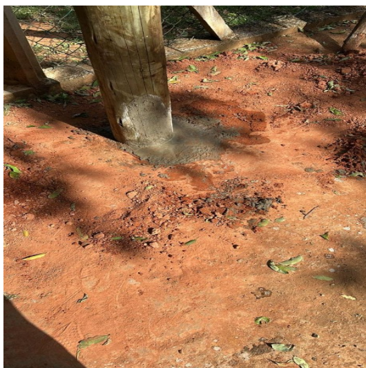
INSTALAÇÃO DE EUCALIPTO TRATADO PARA REDE DE PROTEÇÃO NO ESTADIO EM TIMBUÍ
