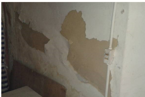
G - Descolamento com pulverulência (Desgaste de reboco)
