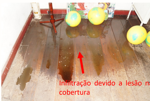
Infiltração devido à lesão na cobertura
